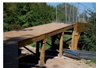
Passerelle bois sur le Vern à Neuvic
