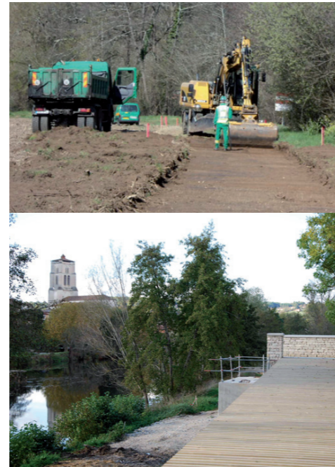
Travaux Véloroute Voie Verte
