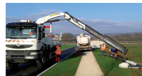
Pose des candélabres - SDE 24 et Bouygues Energie Service
