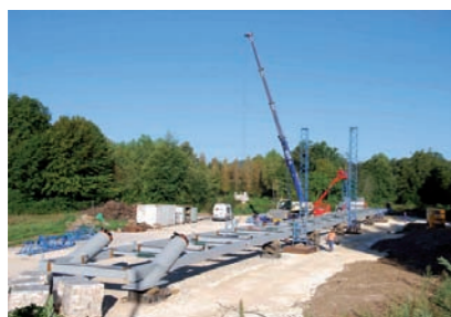
Montage de la passerelle de Montrem
