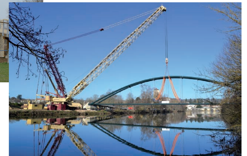
Grutage de la passerelle à Saint-Astier
