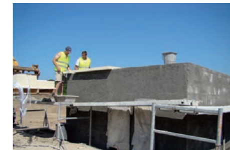
Réalisation des murets techniques - ent. GODBILLOT
