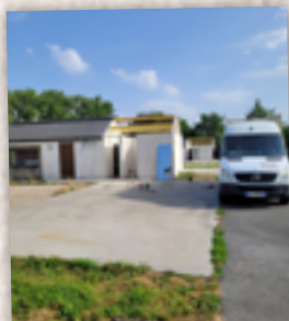
Travaux Aire d'Accueil des Gens du Voyage
