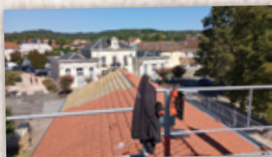
Réfection toiture Maternelle du Centre à St-Astier
