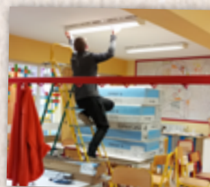
Travaux de rénovation énergétique Maternelle / ALSH à Neuvic
