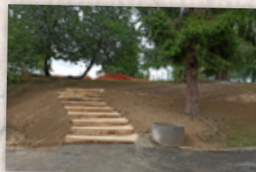
Travaux cheminement de l'école à Montrem
