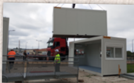
Mise en place classe modulaire UEMA
